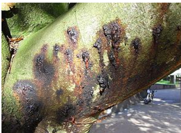
Korstvorming door het indrogen van de vlekken.
